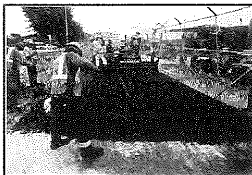
Trabajos de rastrilleo en la junta de unión de carpeta asfáltica nueva con existente
