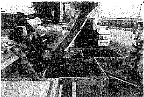
Fundición de registros electricos anivel de rasante terminada
