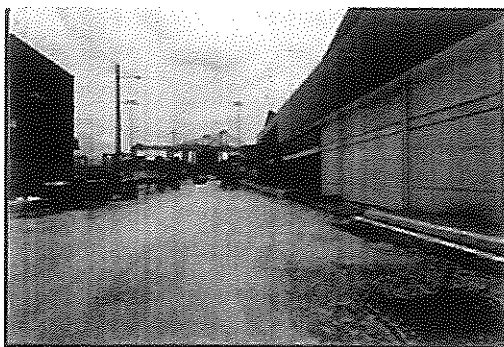
Estado actual de la calle B
