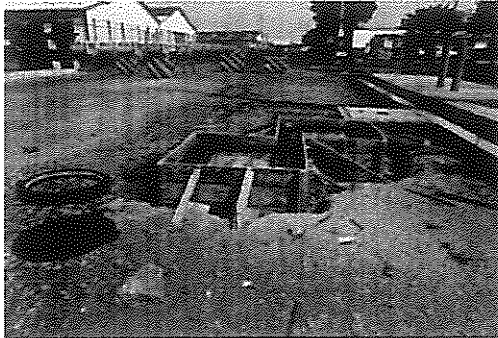
Encofrado en registros eléctricos
